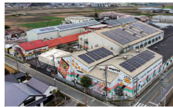
マサヤ工場に設置した太陽光パネル
